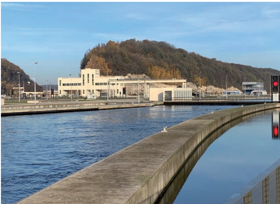
Figure 3 The lock at Ternaaien.
