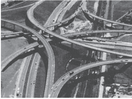
Figuur 8 Illustratie bij het artikel over krommen die door Rijkswaterstaat werden toegepast bij de bouw van fly-overs, door Henk Mulder en Jan van de Craats, in Pythagoras 28-3.
