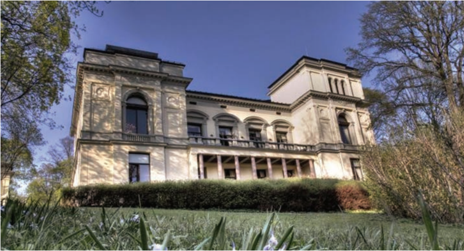
Het gebouw van de Norwegian Academy of Science and Letters
